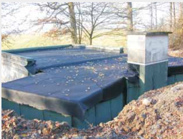
neue Flachdachabdichtung
