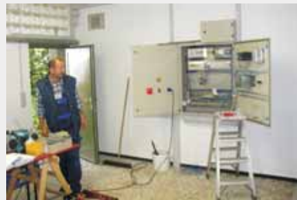
Ergänzungsarbeiten am Schaltschrank
