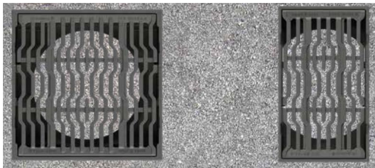
Abbildung 12: Leistungsstärkere Straßeneinläufe [21]
